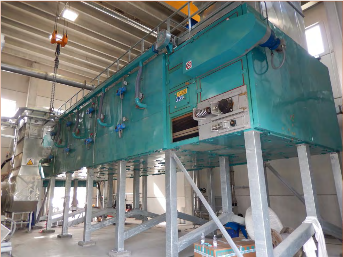
Impianto di essiccazione fanghi industriali completo di forno, trafilè, scambiatore, condotti. Depuratore di Jesi (AN).
