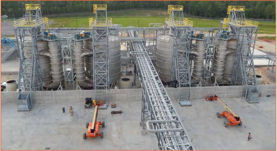
Impianto per produzione pigmenti industria chimica (Augusta – Georgia USA). Reattori di Processo, Draft-Tube (acciaio speciale AVESTA 2205), Piping, Serbatoi di stoccaggio, Strutture - Costruzione, spedizione e installazione on site
