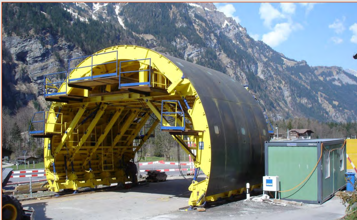
Cassero per galleria, completo di carro traslazione – Mitholz Tunnel, Svizzera
