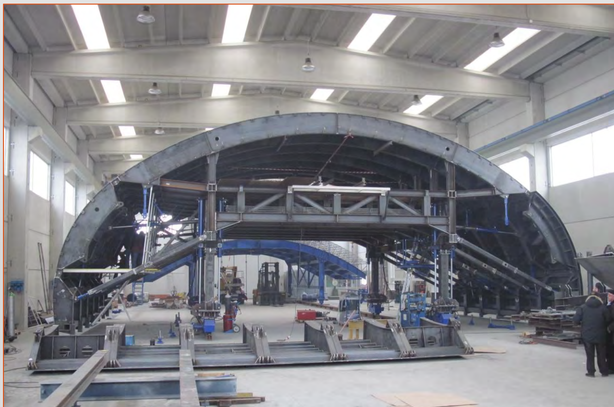
Estensione Linea 7 Metropolitana di New York City (NY, USA). Impianto completo di cassero tunnel, carro traslazione, carro posa-ferri, carroponte sollevamento armatura e sistema distribuzione calcestruzzo
