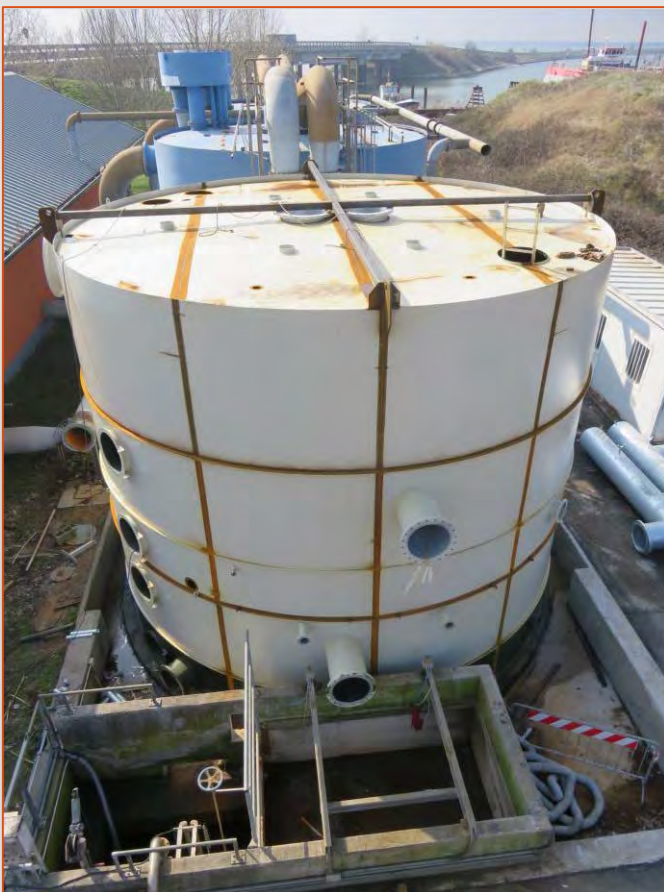
Impianto di essiccazione fanghi industriali completo di forno, trafilè, scambiatore, condotti. Depuratore di Jesi (AN).
